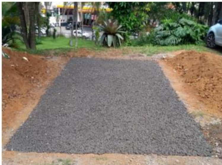
Figura 6: Concreto permeável aplicado em vaga de veículos leves
