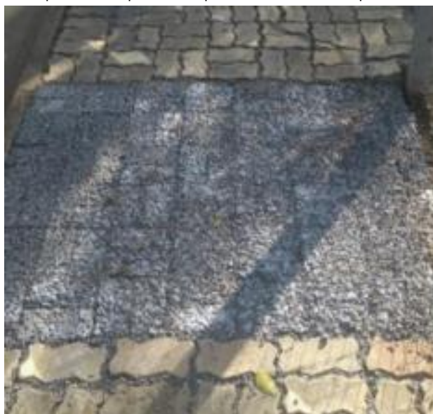
Figura 7: Concreto permeável aplicado em pisos intertravados em pavimento para pedestres
