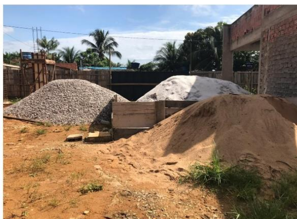
Figura 02 – Armazenamento de agregados da obra.
