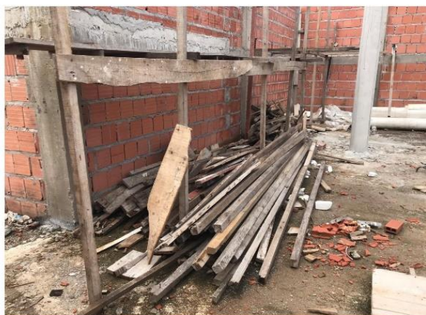
Figura 03 – Separação da madeira para reutilizar
