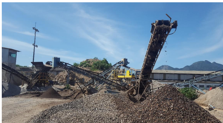
Figura 6 - Usina de Reciclagem Ureserra (autores)
