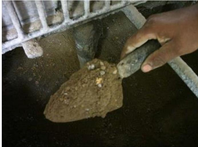
O traço inicialmente dosado para se obter a mistura P6 foi ajustado para P3 (cimento 1,00: areia 0,14: GRAPP 0,06: água/cimento 0,30), mantendo, desta forma, certo grau de segurança para viabilizar o início da fabricação e preservar os equipamentos.
