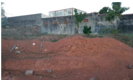
Figura 1 - Depósito de solo proveniente de escavação
