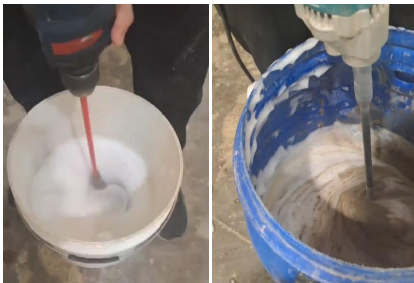
Figura 3: Produção da espuma e do CCE
