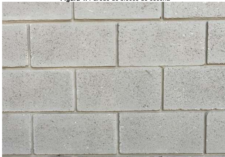
Figura 4: Parede de blocos de escória
