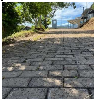
(b) Pavimentação da Vila Reciclos
