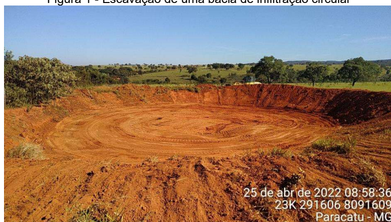
Figura 1 - Escavação de uma bacia de infiltração circular
