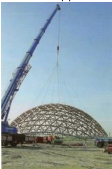
Figura 1 – Construção da Geodésica de papelão (6) .
