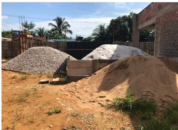
Figura 02 – Armazenamento de agregados da obra.
