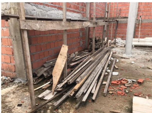
Figura 03 – Separação da madeira para reutilizar
