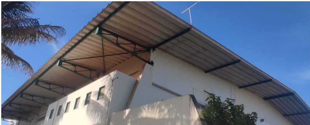
Figura 4 - Telhado metálico trapezoidal do SESI Taguatinga. Fonte: Os autores, 2023.
