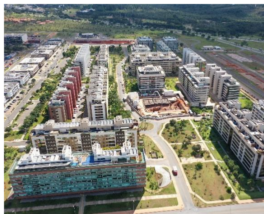
Figura 4 – Vista área da SQNW 111, Brasília/DF. Fonte: Autorial.
