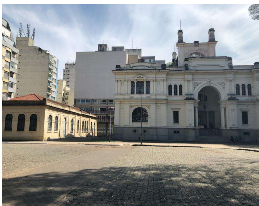
Figura 1 - Conjunto do AHM: Edifício Ramos de Azevedo à direita, Anexo à esquerda e Torre da Memória ao fundo.
