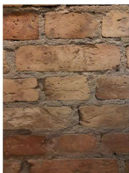
Figura 3 - Paredes internas do subsolo.
