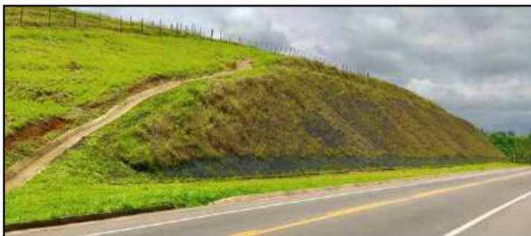
Figura 2: Talude vegetado em rodovia.
