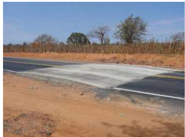
Figura 4 Vista da pista com lombada de redução de velocidade (M4)
