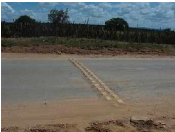
Figura 3 Vista da pista com tachão de redução de velocidade (M3)
