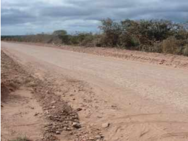
Figura 1 Vista da pista com pavimento de terra (M1)
