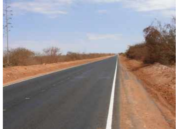
Figura 2 Vista da pista com asfáltico (M2)
