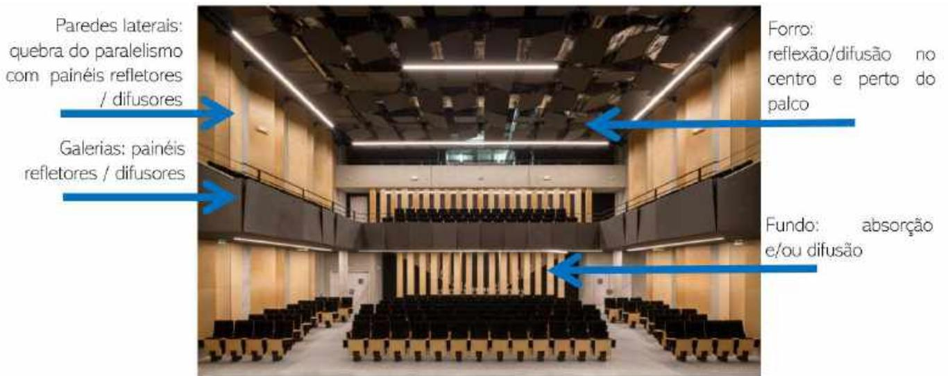
Figura 6 - Uso de refletores nas paredes laterais e no teto quebram o paralelismo entre as faces do auditório. (Fonte: adap. VALCHROMAT, 2019).
