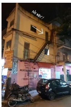
Figura 1 - Escadas de acesso e circulação vertical executadas de forma desregrada Fonte: Própria
