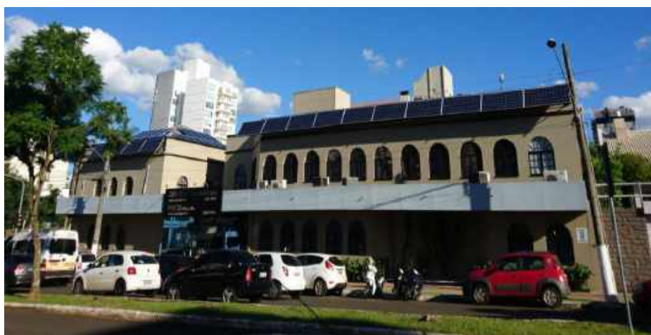
Figura 1 - Exemplo de sistema de microgeração distribuída fotovoltaico instalado entre a AUC e AUT (Autores, 2019).
