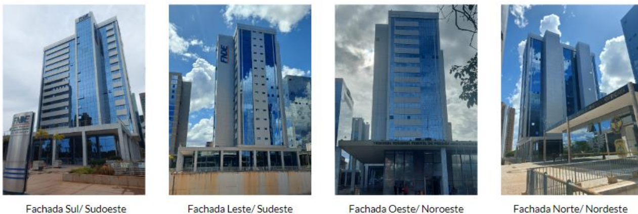
Figura 1 – Fachadas do Edifício FNDE. Fonte: Autores, 2023.
