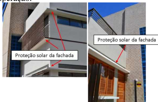
Figura 8 – Elementos de proteção solar de alvenaria que foram considerados na simulação #1.
