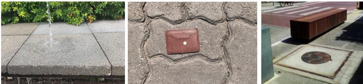
Figura 3 – Materiais analisados no projeto: (à esquerda) piso drenante; (ao centro) piso intertravado e (à direita) madeira e concreto.
