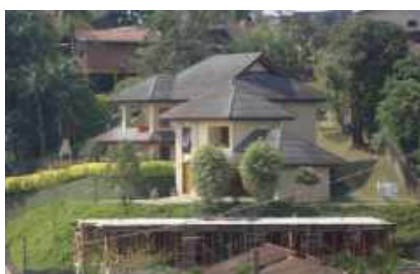
Figura 3 – Fachada da Residência 1.
