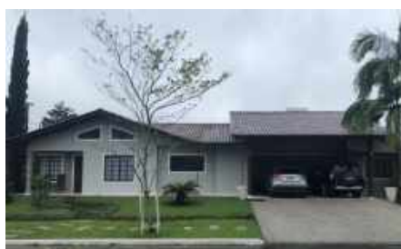
Figura 4 – Fachada da Residência 2.
