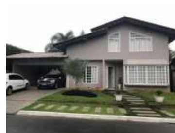
Figura 5 – Fachada da Residência 3.
