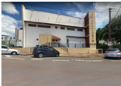
Figura 1 – Vista externa do auditório. Fonte: https://www.google.com.br/maps . Acesso em: 07 mai. 2022.
