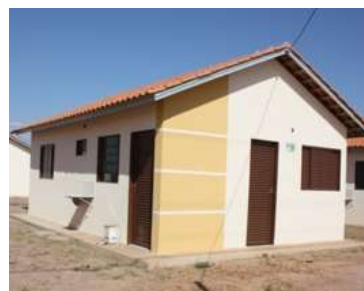
Figura 4 – Imagem exterior da edificação.
