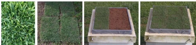
Figura 2 – Instalação da vegetação nos telhados verdes. Fonte: Elaborado pelos autores, 2023.
