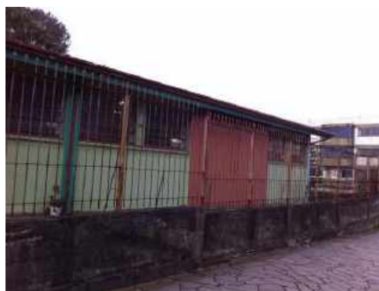
Figura 2 – Fachada oeste da biblioteca.
