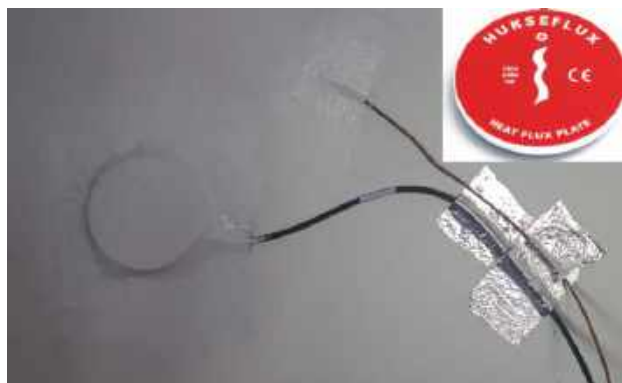
Figura 4 – Termopares e Placas de fluxo de calor instalados nas paredes.
