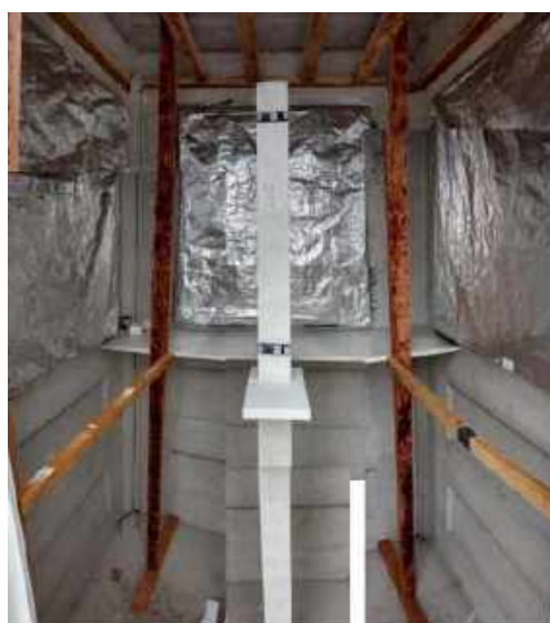
Figura 6: Fotomontagem interna do apoio estrutural de madeira (KAVISKI, 2018).
