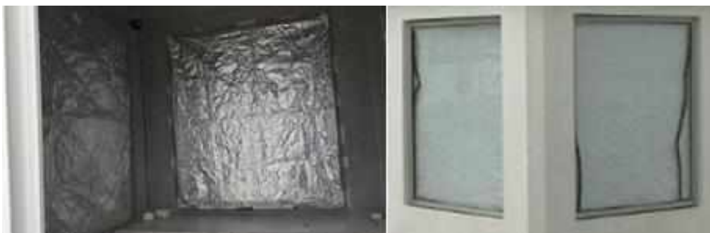
Figura 4: Fechamento das aberturas das guaritas.
