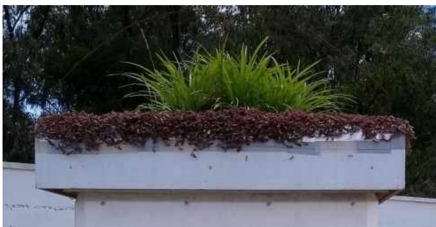
Figura 5: Sistema de cobertura vegetada do MV, um ano após o plantio.
