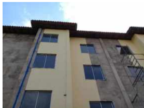
Figura 2 – Fachada oeste com pintura não finalizada
