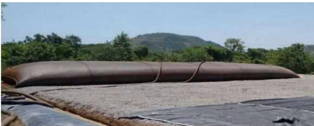
Figura 1 - Bag semipreenchido de lodo. Fonte: Gontijo Neto, 2018.
