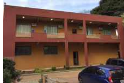
Figura 5 – Fachada lateral esquerda.
