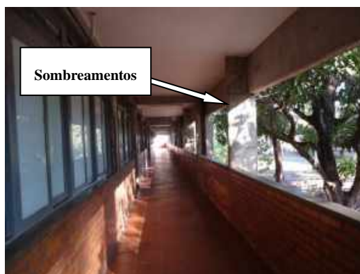
Figura 2– Sombreamento bloqueando a incidência da radiação solar direta nas salas. Pavimento Superior
