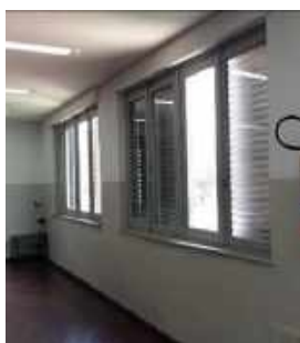
Figura 14 – Detalhe das janelas.
