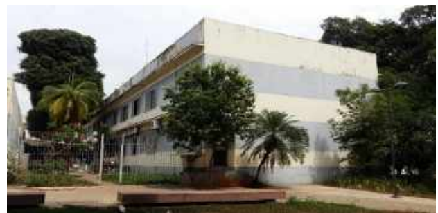
Figuras 12 – Fachadas Sul e Leste do edifício.
