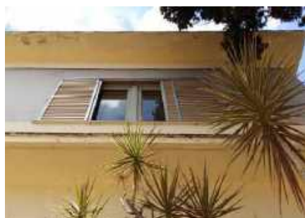
Figura 13 – Detalhe das janelas.
