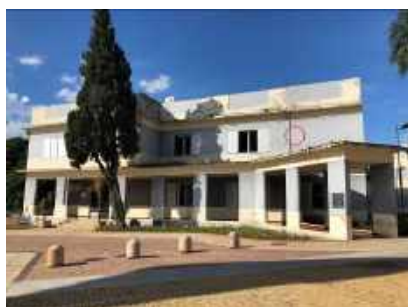
Figura 2 – Em vermelho, região da fachada Oeste escolhida para realização do ensaio de transmitância térmica.
