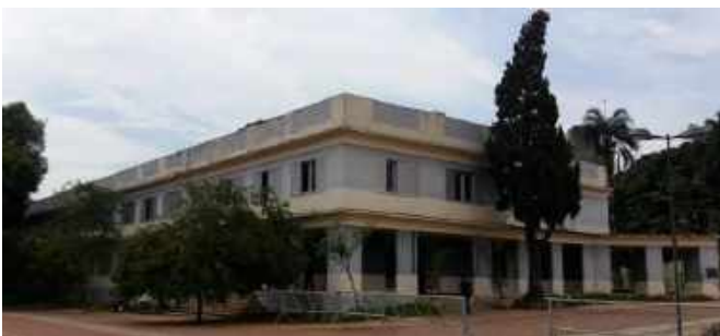
Figuras 11 – Fachadas Norte e Oeste do edifício.
