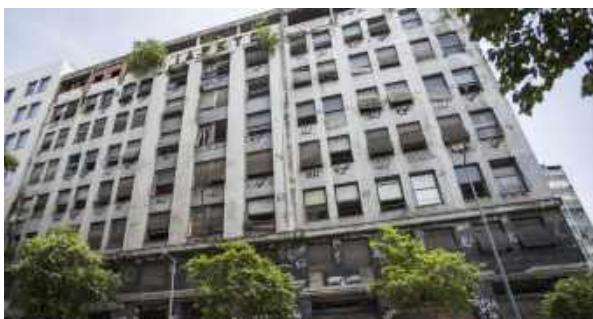
Figura 1 – Fachada do antigo prédio do IAPETC. Fonte: https://oglobo.globo.com/rio/anos-de-descaso-no-centro-do-rio-20502600
