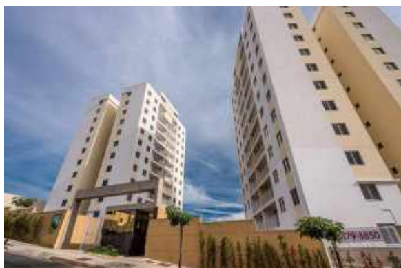
Figura 1 – Fachadas das edificações
