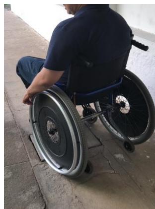
Figura 10 – Piso desgastado e caixa de passagem (BARROS, 2018)
