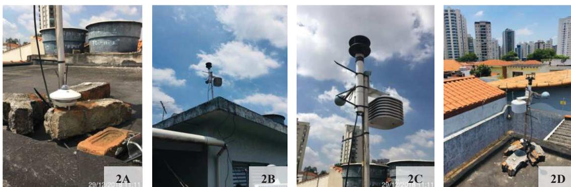
Figuras 2A, 2B, 2C e 2D (da esquerda para a direita) – Subponto da laje de cobertura com equipamentos da Estação Científica *Campbell* (B), incluindo anemômetro (C) e piranômetro (A), e um *Hobo* (D) (NOVAES, 2020)
