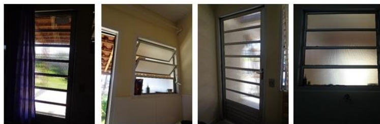
Figura 5 – Iluminação natural prejudicada pelas ampliações da moradia com painéis leves em madeira. Fonte: Autores.
