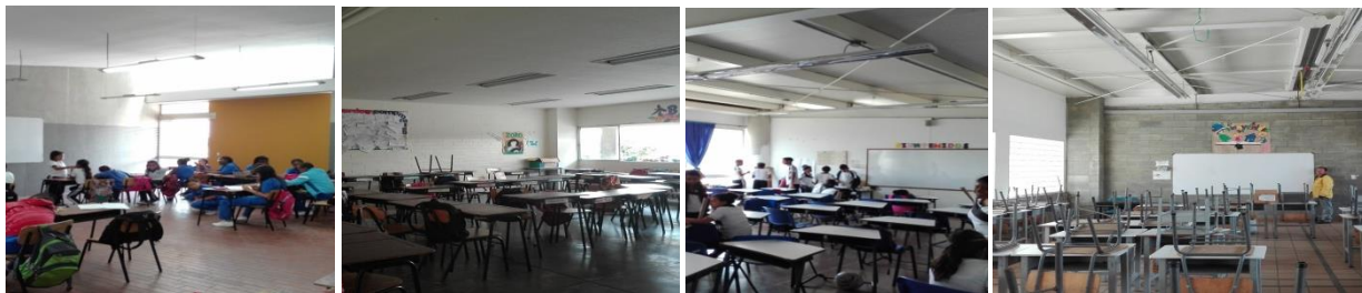
Figura 03: Interiores de las aulas, tipo de aberturas y acabados al interior
