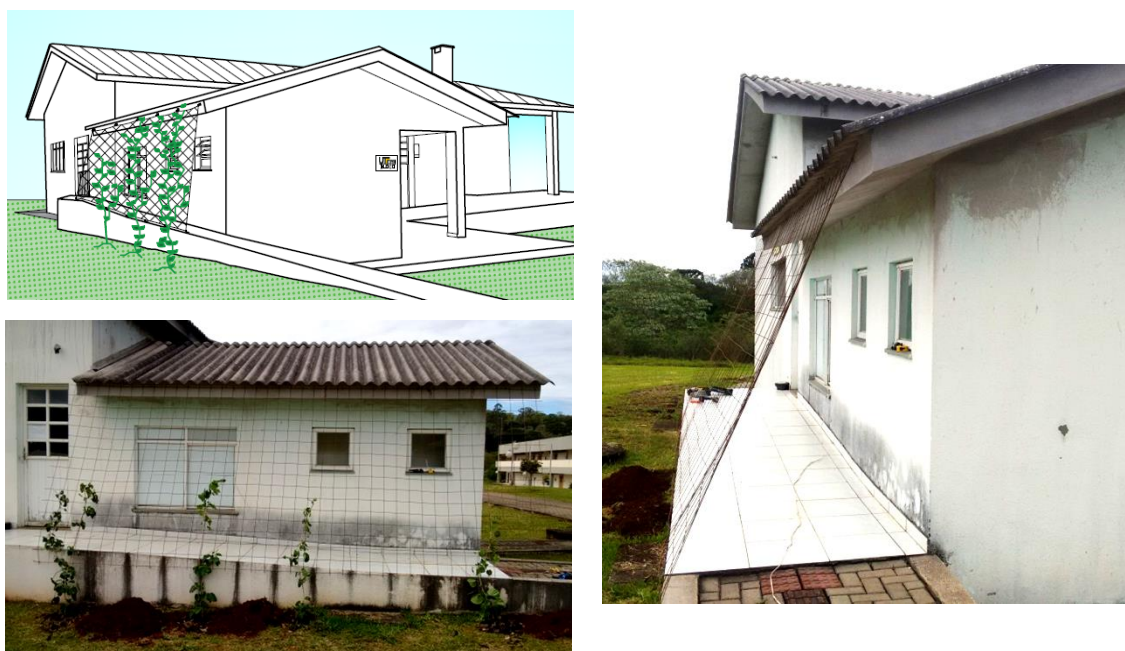
Figura 2 – Estrutura da Cortina Verde sobre a edificação 1.
