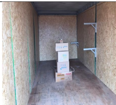
Figura 4 – Instalação das placas de OSB (AUTORES, 2019).
