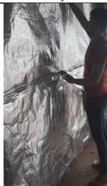
Figura 3 – Instalação da Manta Térmica de Alumínio (AUTORES, 2019).
