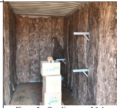
Figura 5 – Contêiner com Lã de Vidro (AUTORES, 2019).
