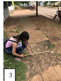
Figura 2 e 3 – Travessia sem sinalização e com irregularidades no piso na área central (AUTORES, 2019).
