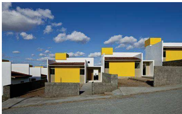
Figura 2: Fachada da HIS Wirton Lira. Fonte: Jirau Arquitetura
