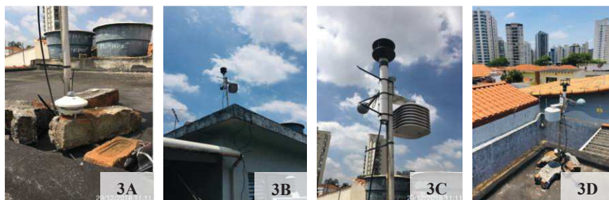
Figuras 3A, 3B, 3C e 3D (da esquerda para a direita) – Subponto da laje de cobertura com equipamentos da Estação Científica Campbell (B), incluindo anemômetro (C) e piranômetro (A), e um Hobo (D) (NOVAES, 2020)
