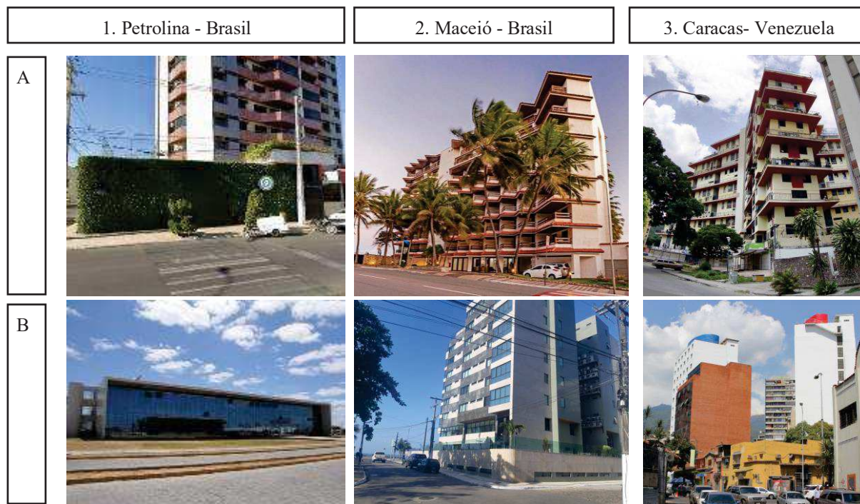
Figura 2 - A) Edificações com envoltórias adequadas ao clima. B) Edificações com elementos inadequados ao clima
