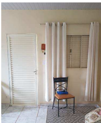
Figura 3- Porta, janela, piso e forro da construção.
