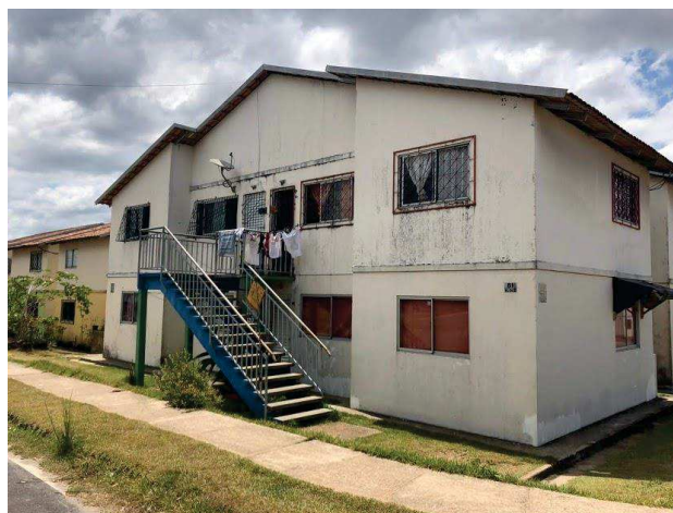
Figura 2 – Bloco do residencial José Rodrigues de Sousa.
