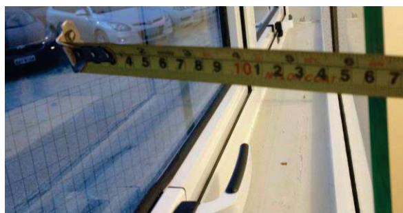
Figura 2 - Instalação de janela duplicada no interior de ME
