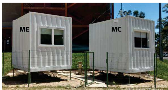
Figura 1 - Vista geral dos módulos da CBBC
