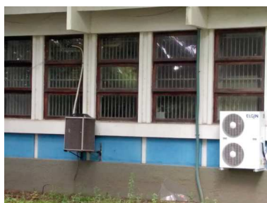
Figura 2 – Vista externa das aberturas do ambiente estudado.
