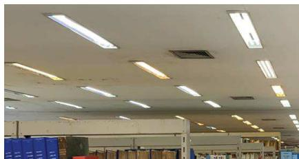
Figura 6 – Mistura de temperaturas de cor
