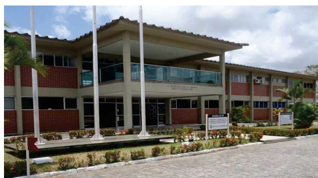
Figura 2 - Edificação do pavilhão de comando do 4ºBPE.
